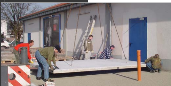
Bodenplattenmontage
